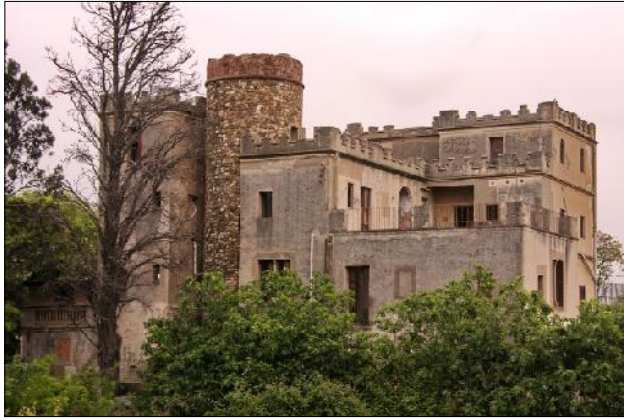
Imatge d'abans de la restauració.
