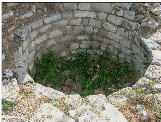
Base de la torre del castell.
