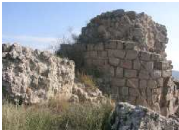
Torre i muralla del castell.
