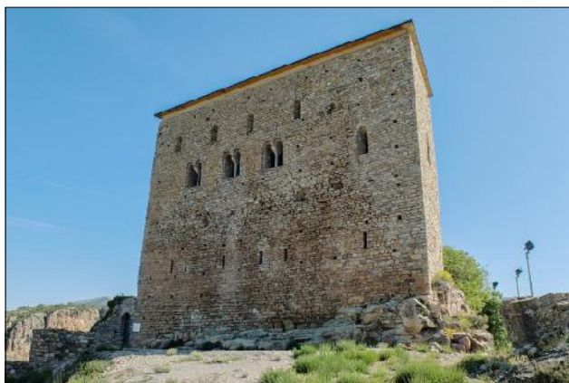
Façana principal del castell residencial.
