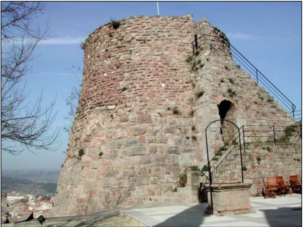
Torre de la Minyona. Fotografia de Jordi Gironès
