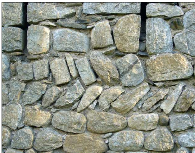
Opus spicatum a les parets de l'edifici.
