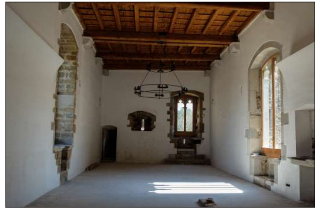
Sala interior del castell en restauració.
